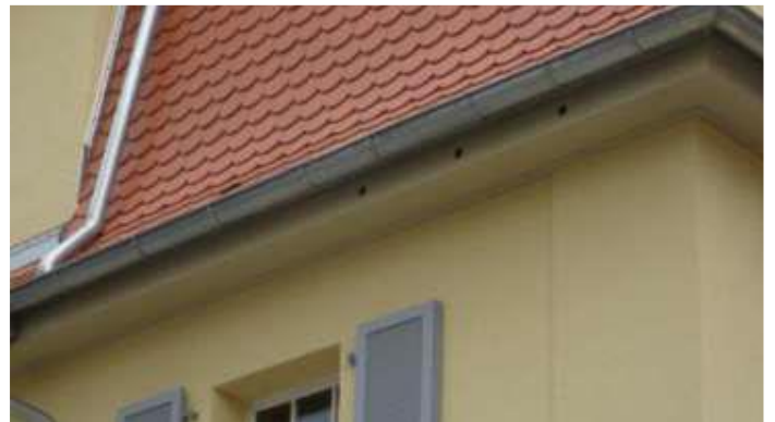
Bei Sanierung im Dachkasten eingebaute Brutkammern
